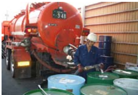
ドラム缶吸引処理作業 バキューム車で吸引後地下ピットへ投入
