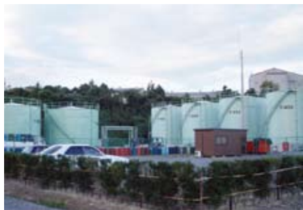
タンクヤード
