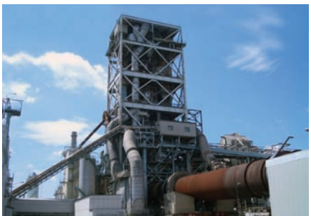
太平洋セメント(株)藤原工場 5号キルンタワー
