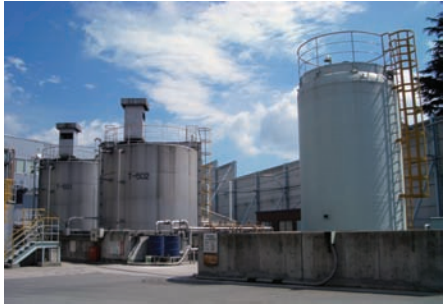
太平洋セメント(株)藤原工場内製品供給タンク 出荷製品は製品供給タンクへ一時貯蔵
