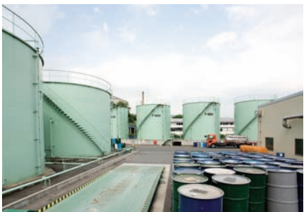
タンクヤード
