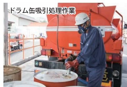
バキューム車で吸引後地下ピットへ投入
