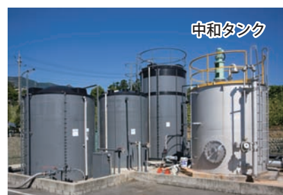
入荷廃液を 中和タンクへ投入し中和処理
