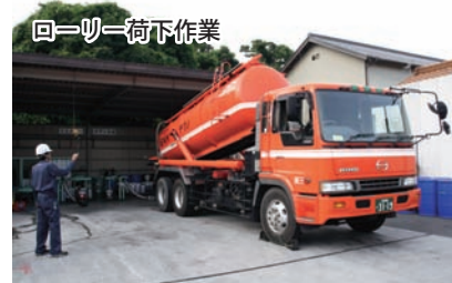
入荷した廃油等は地下ピットへ投入
