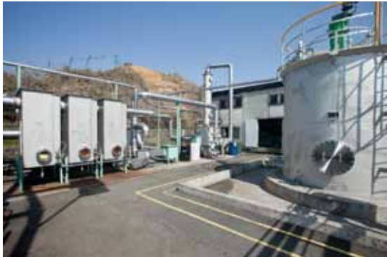
北勢工場の臭気測定値は規制基準を十分クリアしていますが、お客様のニーズに応える再資源化処理の拡充をめざして整備した第一工場脱臭設備（吸収塔）です。
