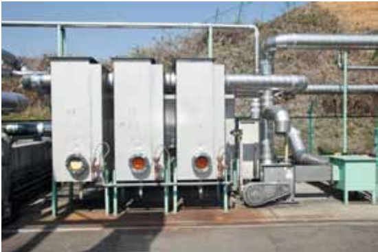
北勢工場の臭気測定値は規制基準を十分クリアしていますが、お客様のニーズに応える再資源化処理の拡充をめざして整備した第一工場脱臭設備（吸収塔）です。
