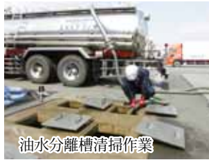
油水分離槽清掃作業
