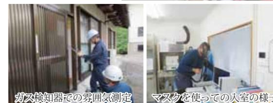
ガス検知器での雰囲気測定
