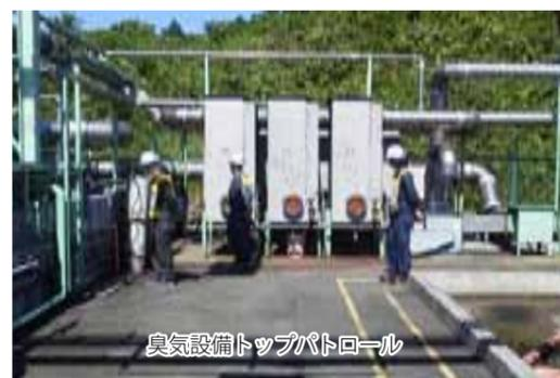
北勢工場の臭気測定値は規制基準を十分クリアしていますが、お客様のニーズに応える再資源化処理の拡充をめざして整備した第 1 エリア脱臭設備（吸収塔）です。
