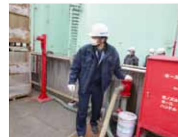
消火ポンプ起動操作
